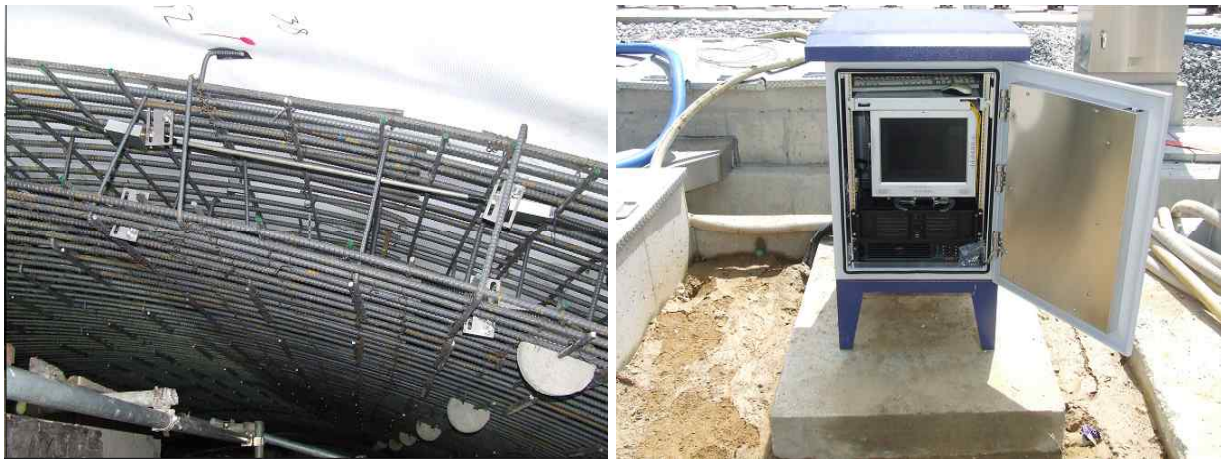
(a) 경부고속철도 KTX ○○공구 노반 신설 기타 건설공사 (○○터널)
